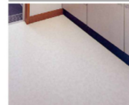
③ クッションフロア 施工例
